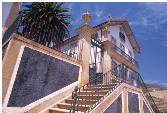
A IMPONENTE ESCADARIA QUE DÁ ACESSO AO PÁTIO DA CASA
